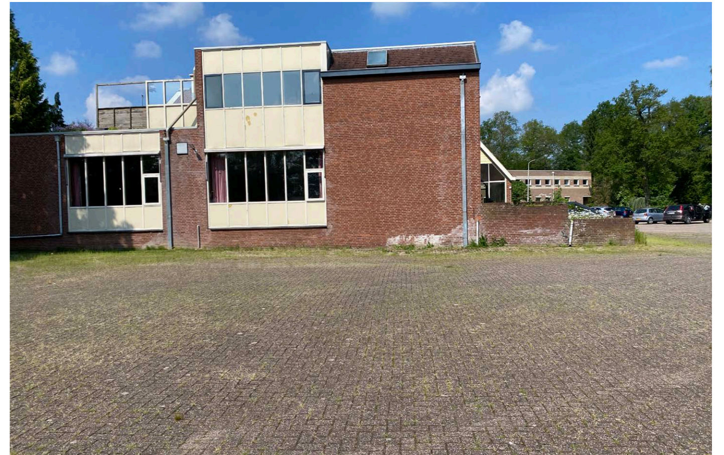
Het te slopen gebouw
