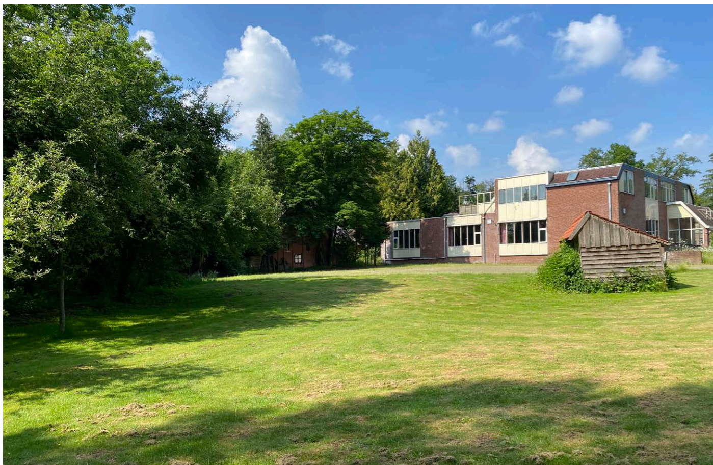
Het projectgebied gezien in de richting van het te slopen gebouw
