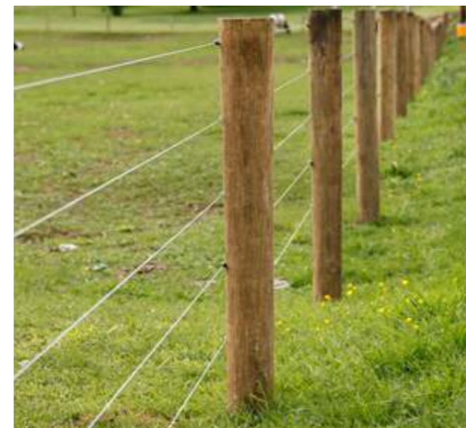
Kastanjehout terreinafschieding met staaldraad
