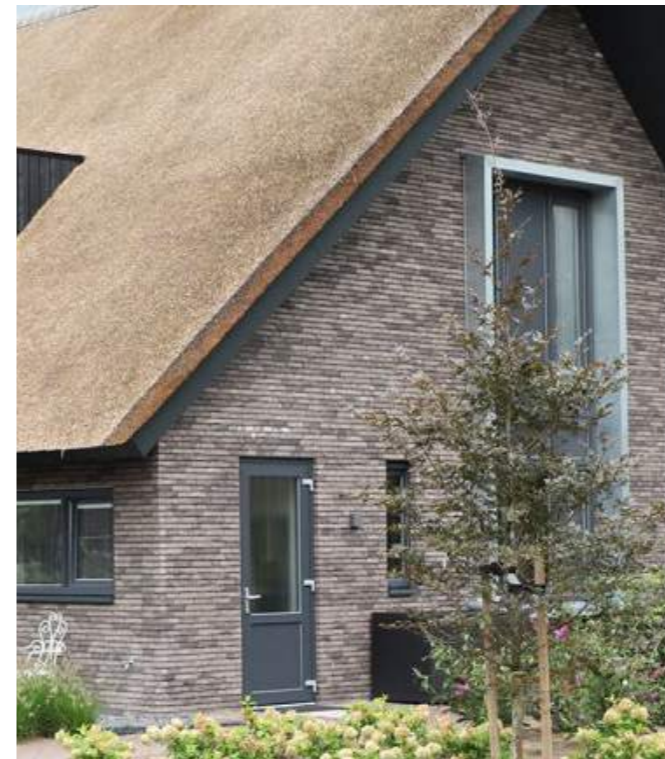
Gevel van metselwerk
