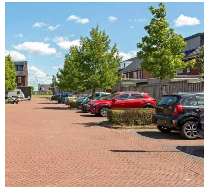
Erftoegangsweg en parkeerplaats van klinkerverharding
