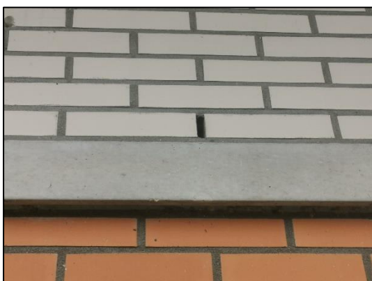
Figuur 1.6: Het gebouw beschikt over stootvoegen.
