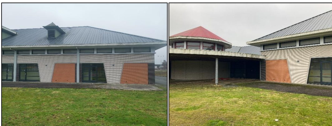
Figuur 1.2 (links): Noordaanzicht van het gebouw; Figuur 1.3 (rechts): Noordaanzicht van het gebouw, met de te slopen koepel.
