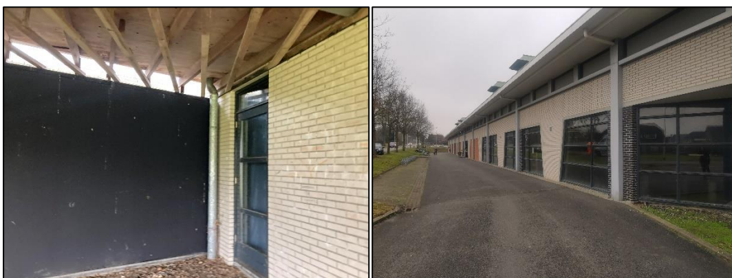
Figuur 1.4 (links): Onderaanzicht koepel; Figuur 1.5 (rechts): Zuidaanzicht van het gebouw.
