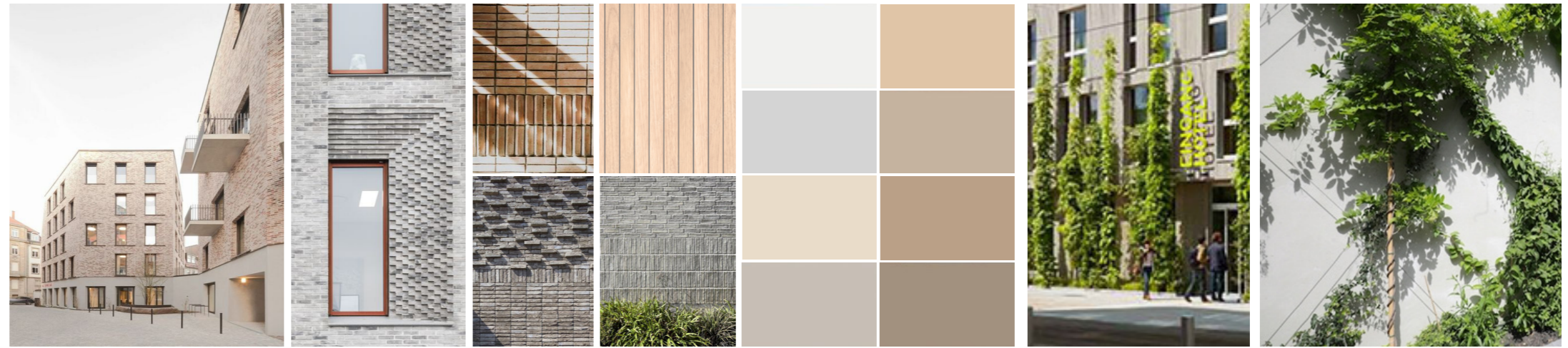
Gemeleerd metselwerk met kleurschakering, diversiteit in metselverbanden en natuurlijke accenten.
