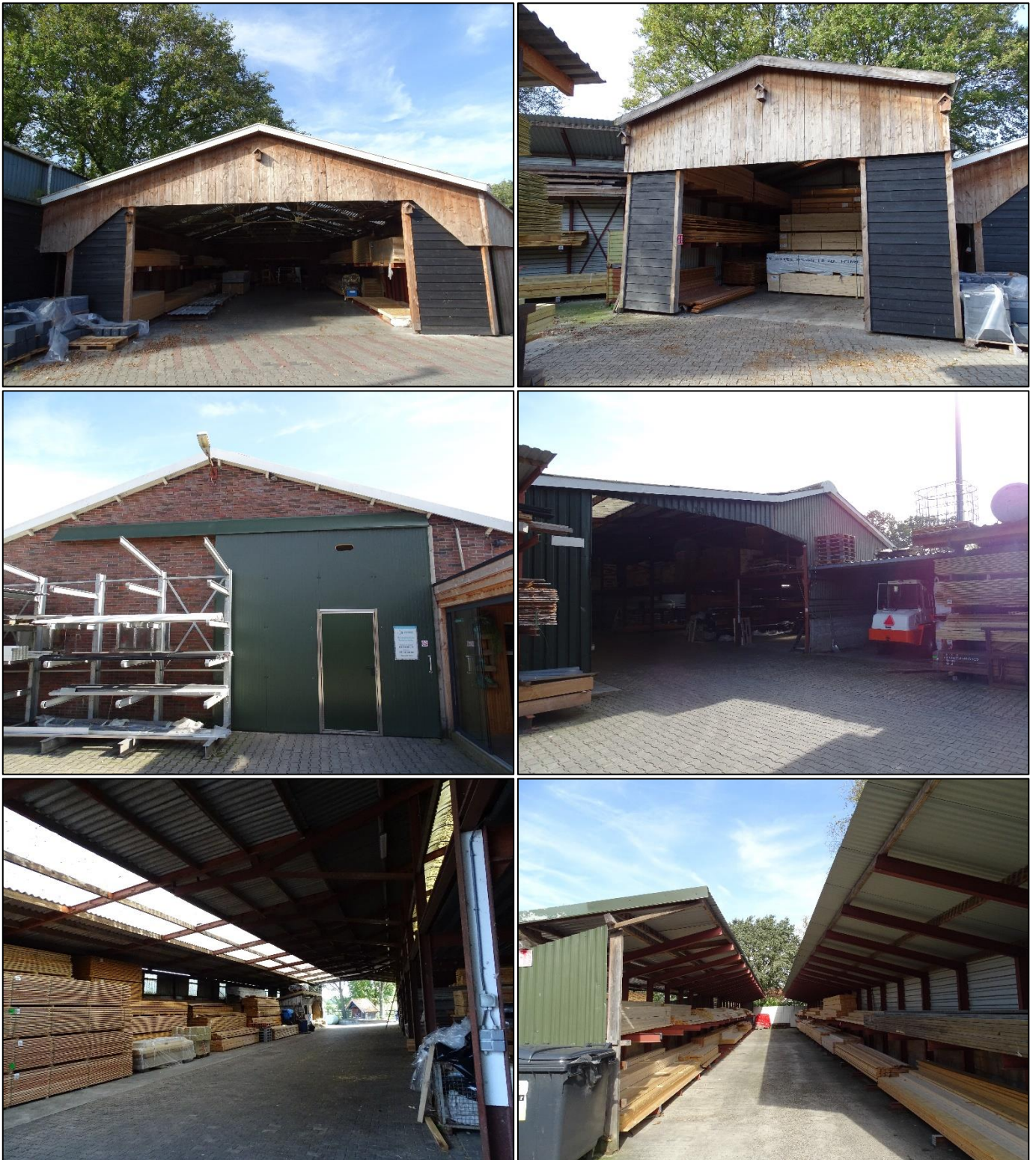
Afbeelding 2, indruk van de bebouwing binnen het plangebied met linksboven de voorzijde van loods 1, rechtsboven de voorzijde van loods 2, linksmidden de voorzijde van loods 3, rechtsmidden de voorzijde van loods 4, linksonder de binnenzijde van loods 4 en rechtsonder de overige metalen opstallen op het terrein (foto's: Laneco, 2023).
