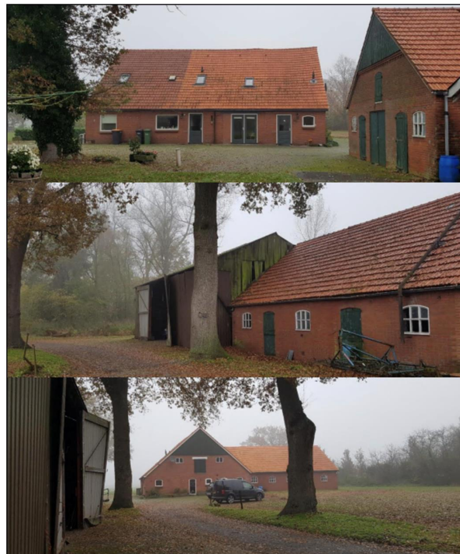
Figuur 4 Foto's van de bestaande bebouwing aan de Fleurweg 1 (bron: Het Oversticht)
