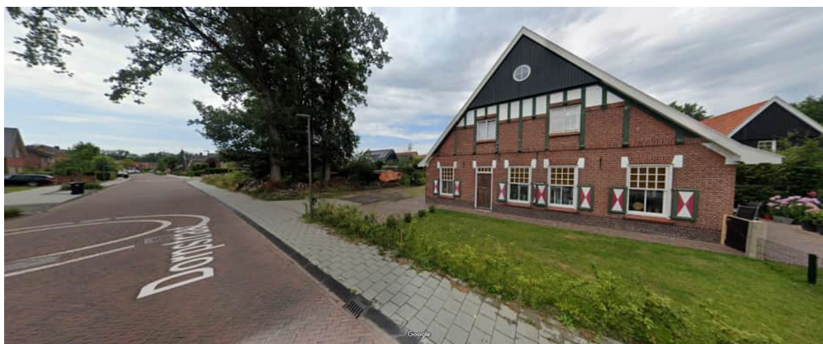
Afbeelding 2.4: aanzicht huidige situatie planlocatie vanaf Dorpstraat ter hoogte van Dorpstraat 47
